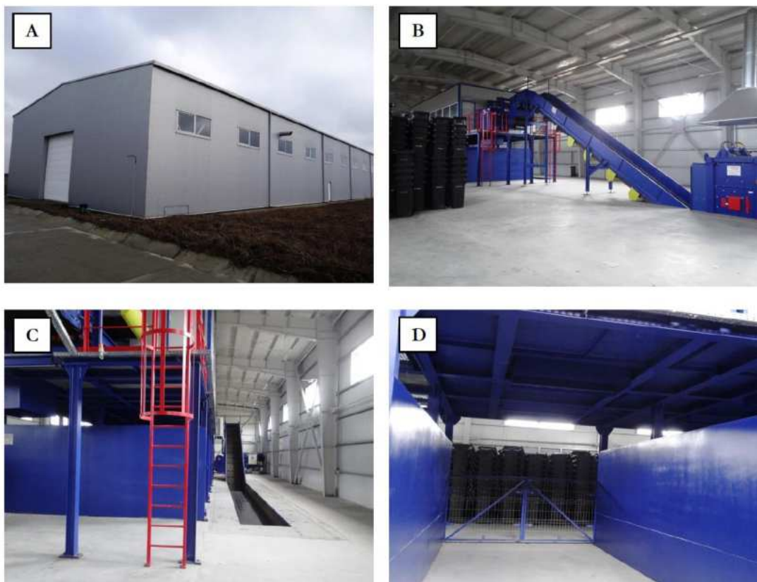
Figura 2 Stația de sortare – (A) Hala de sortare; (B) Stația de sortare; (C) Banda transportoare; (D) Buncăr material sortat
